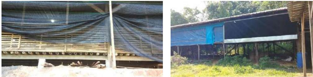
Gambar 1. *Inlet* menggunakan paranet dan *celldack selulose*
